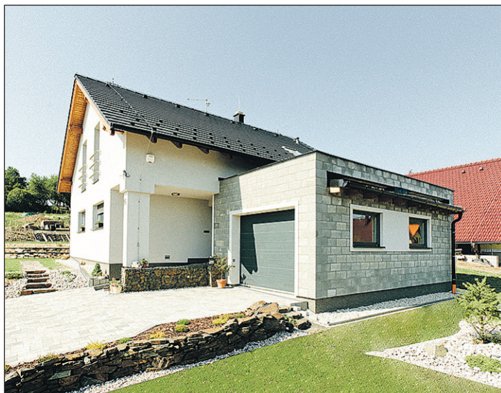
Rodinný dům s garáží z betonového zdiva LIVETHERM, garáž v pohledovém provedení bez nástřiku.
