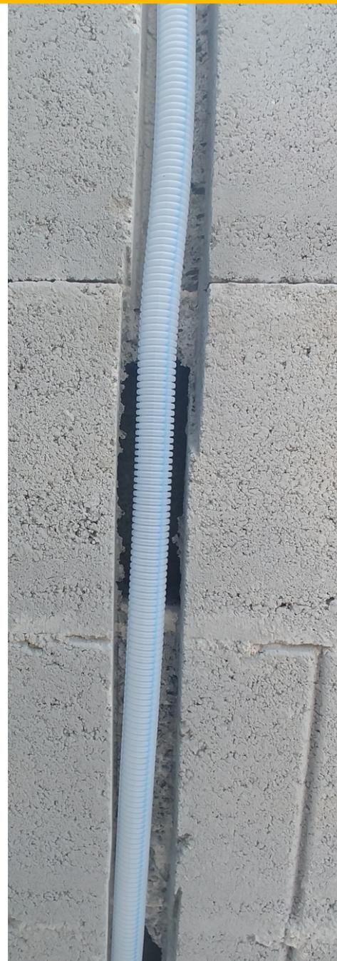
Tento způsob provedení ložné spáry, tzn. drážkování, vysekávání a následná montáž rozvodů je vhodná pro uložení většího množství elektrorozvodů, popř. rozvodů vody a kanalizace.
